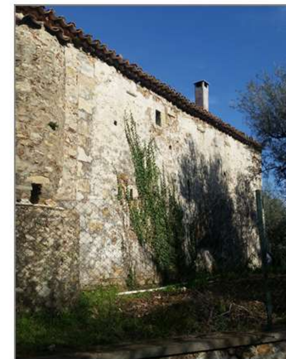
Εικ.Π.52-02: Η δυτική πλευρά του αρχικού κτίριου
