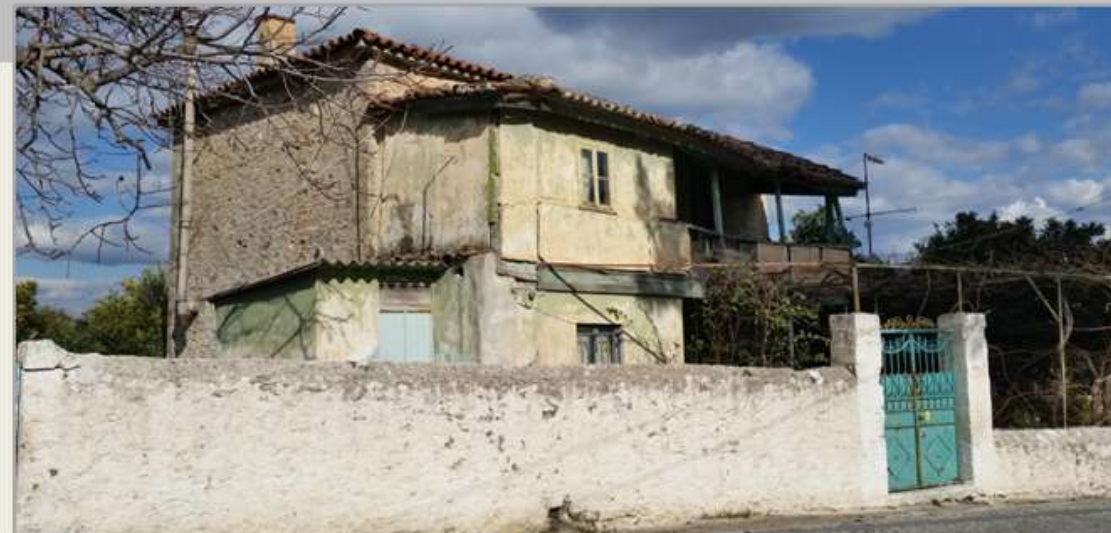
Εικ.Π.50-01: Μέρος του νότιου χαγιατιού έχει κλείσει με τσαπμά για να δημιουργηθεί το μαγειρείο στον όροφο, δίπλα στο χειμωνιάτικο.
