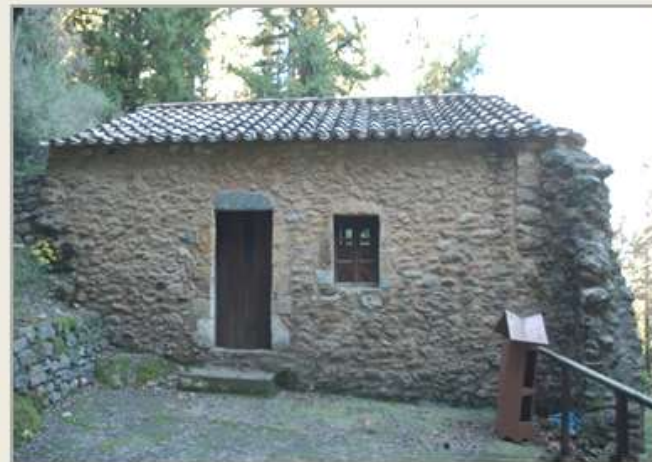
Εικ.Π.25-02: νότια όψη του ναού
