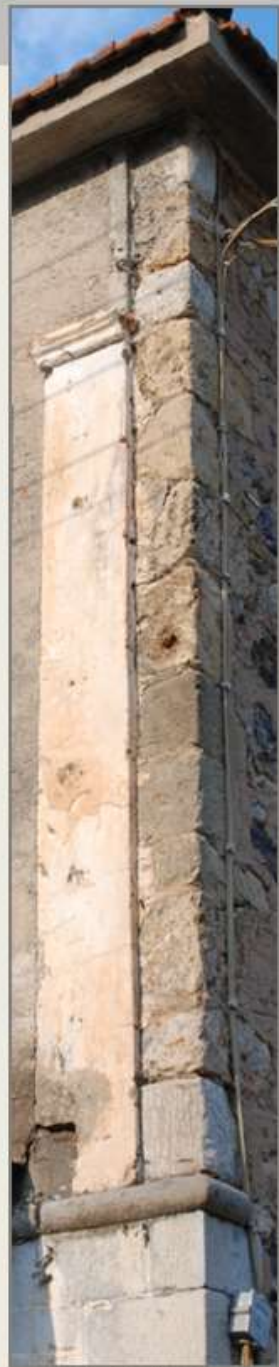
Εικ.Π.47-07: Πεσσός στον όροφο
