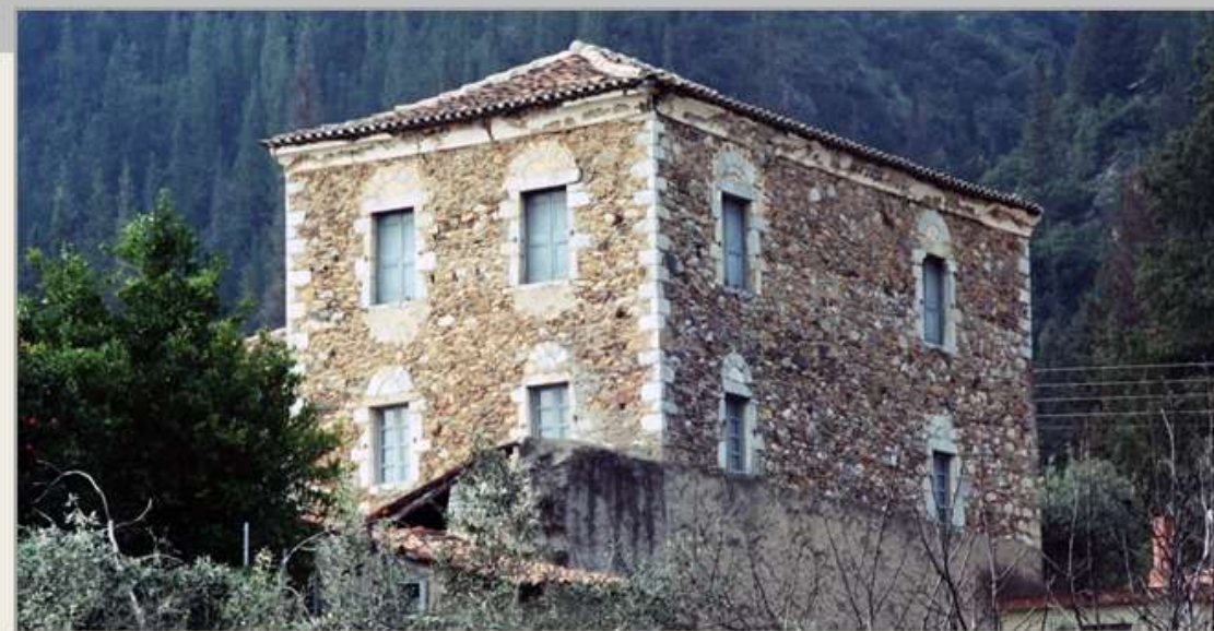
Εικ.Π.36-01: Β/Α άποψη του πύργου όπως ήταν αρχικά
