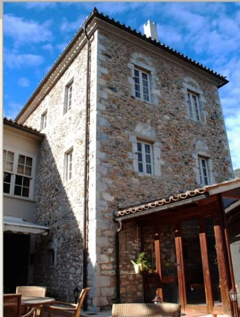
Εικ.Π.35-04: Ν/Α άποψη (εσωτερική) των κτιρίων σήμερα
