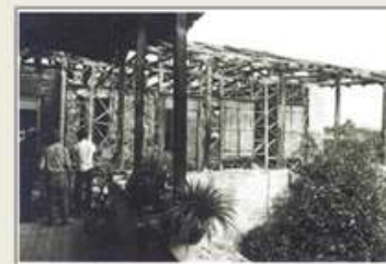
Εικ.02: Οι ξυλόπηκτοι τοίχοι στη φάση των επισκευών (Πηγή: Αρχείο τα. 5 ης ΕΒΑ)
