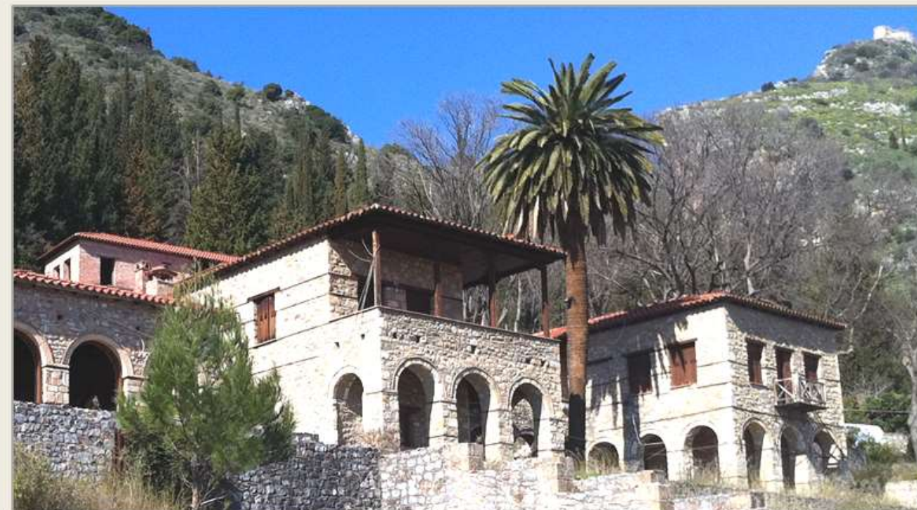
Εικ.Π.34-03: Η νοτιοανατολική άποψη του αρχοντικού μετά την αποκατάστασή του και στο βάθος το Κάστρο του Μυστρά
