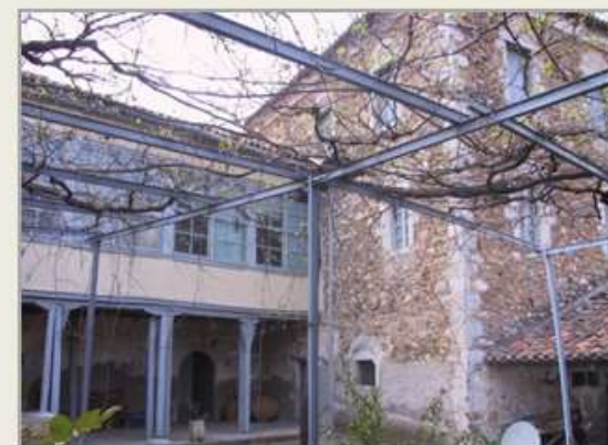
Εικ.Π.36-03: Ν/Α άποψη των κτιρίων (αρχικά)
