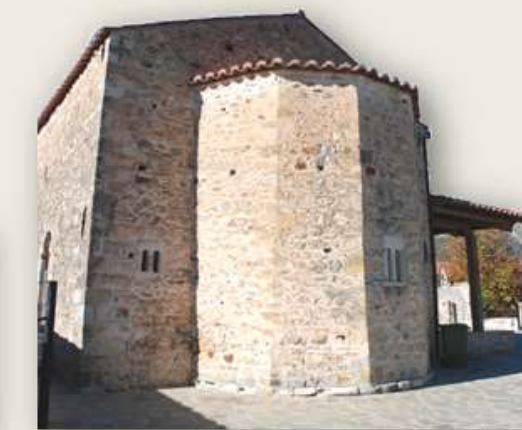
Εικ.Π.22-03: Νοτιοανατολική Όψη
