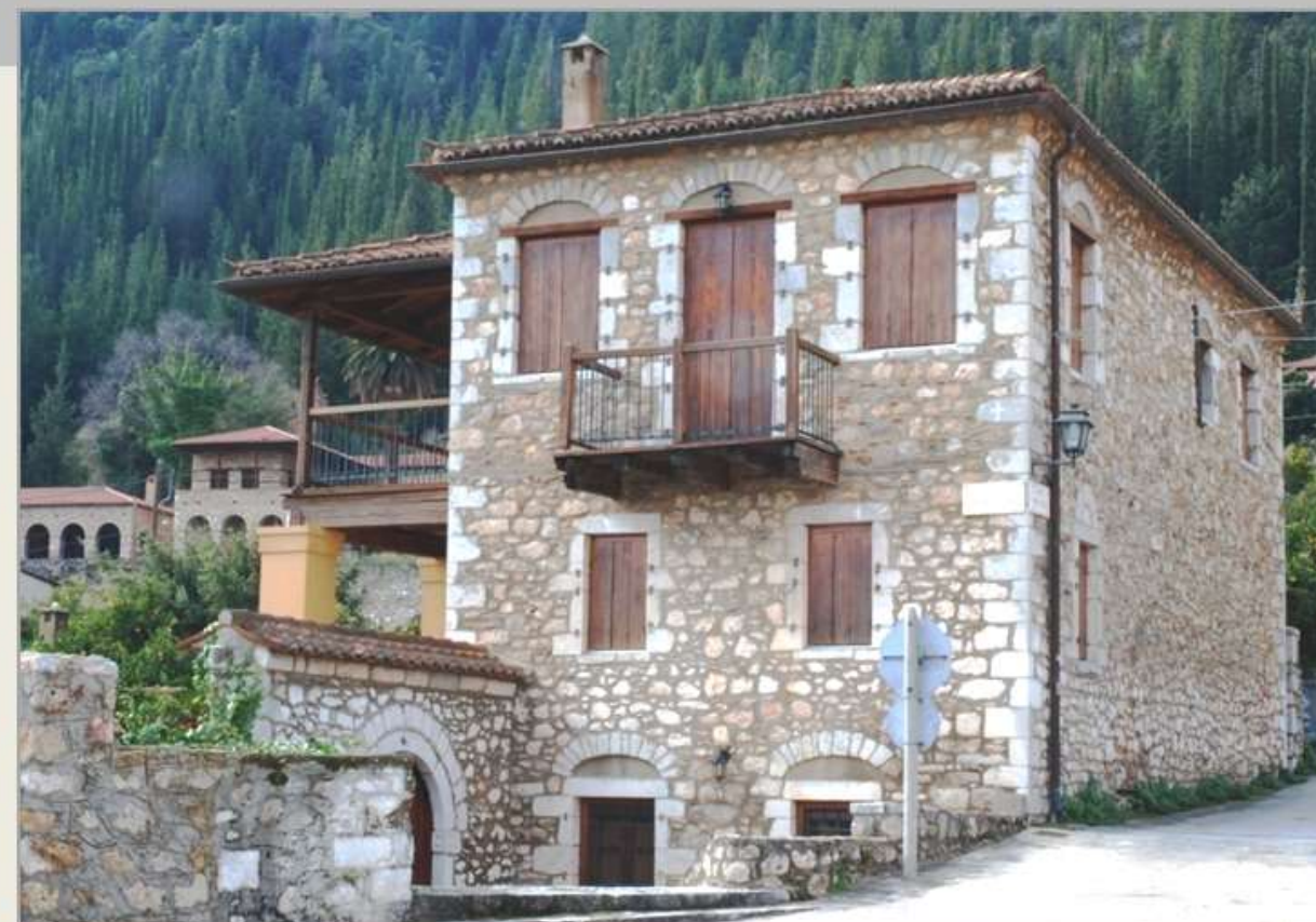
Εικ.Π.44-01: Η βορειοανατολική όψη, μετά τις εργασίες ανακαίνισης & αναστήλωσης
