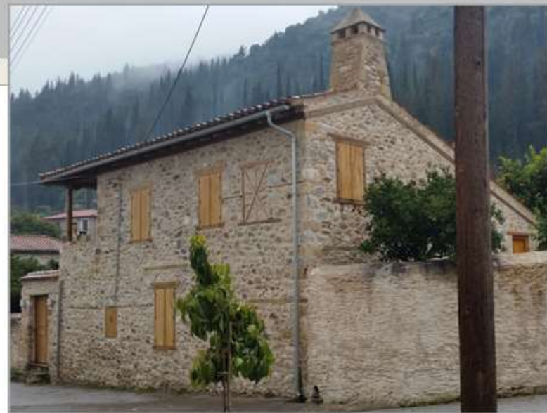
Εικ.Π.37-01: Η Β/Α όψη της οικίας μετά την επισκευή
