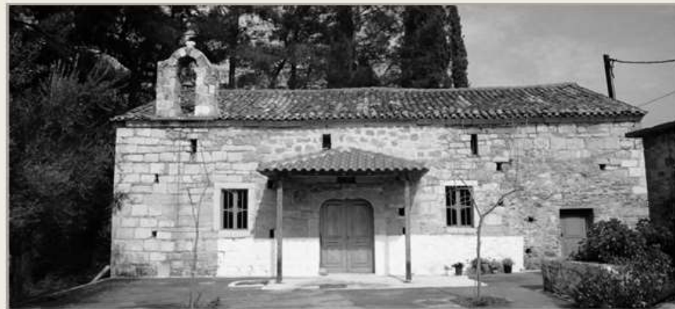
Εικ.Π.28-01: Η νότια όψη (λήψη:2001)
