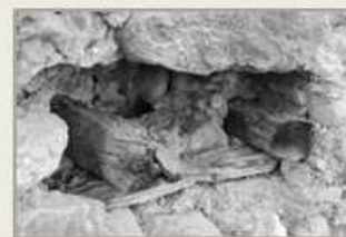
Εικ.04: Εσωτερικές ξυλοδεσιές
