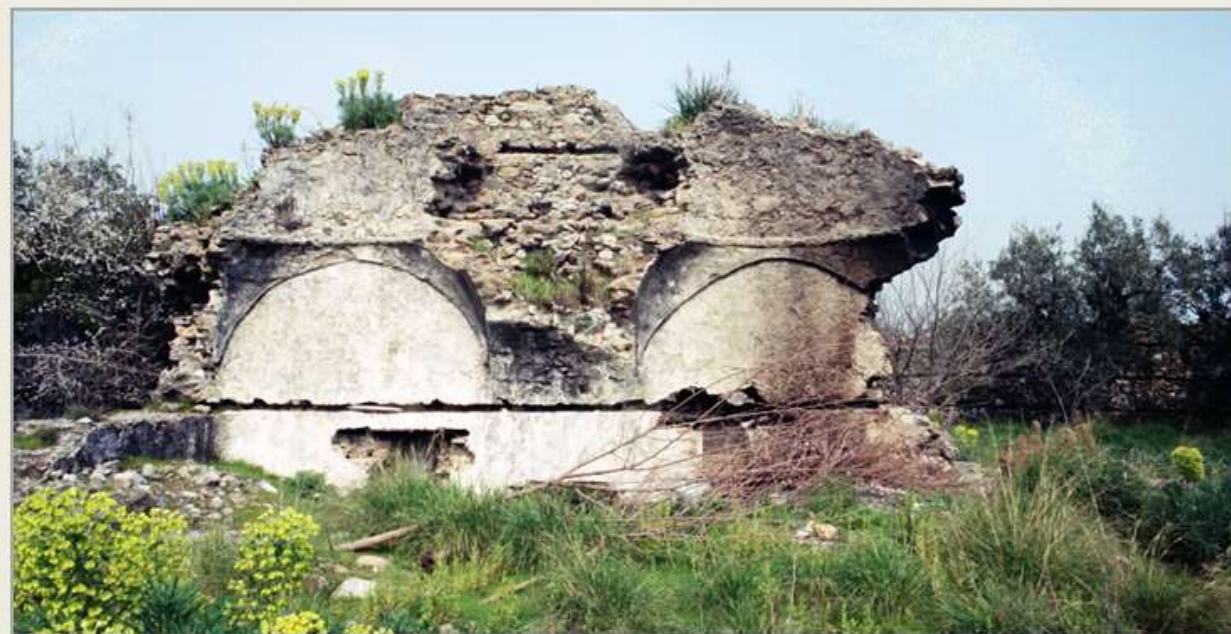
Εικ.Π.53-01: Τμήμα των τοίχων του χλιαρού χώρου του χαμάμ.
