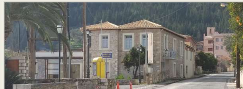
Εικ.Π.46-02: Η βορειανατολική όψη από τον κεντρικό δρόμο
