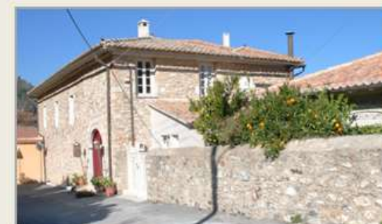
Εικ.Π.36-05: Ν/Δ άποψη (εξωτερική) των κτιρίων σήμερα
