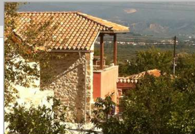
Εικ.Π.37-02: Η Ν/Δ όψη της οικίας μετά την επισκευή
